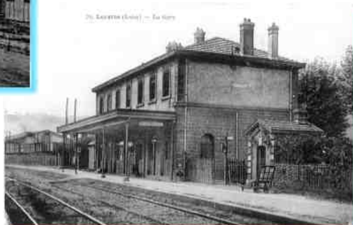
3 avril 1911 - La gare de Lorette avec, dans son prolongement, celle des marchandises. A droite, peut-être les toilettes. Ce qui étonne, c'est la cheminée sur le toit.
